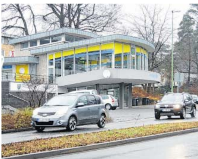
Förderzusage liegt vor: Der Sennestadt-Pavillon soll energetisch saniert und barrierefrei werden.
