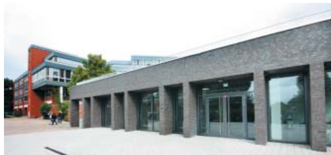
Klinkerbau mit viel Glas: Die neue Mensa ist als Solitär vor dem Gebäude des Berufskollegs errichtet worden. Dieses wird aktuell von fast 4.500 Schülerinnen und Schülern besucht. FOTOS: SUSANNE LAHR
