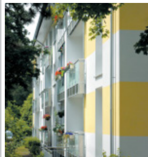
Modernisierung: An Peter- und Vormbrockstraße werden 85 Wohnungen hergerichtet.
