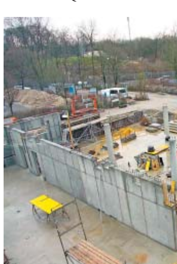
Ein Blick von oben: Aus dem Lehrerzimmer sind die Fortentwicklungen auf der Baustelle an der Rosenhöhe bestens zu verfolgen.
