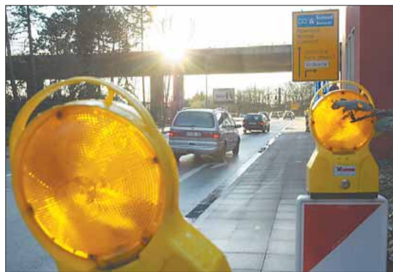
An der Gütersloher Straße haben die Arbeiten gestern begonnen. Sie dauern voraussichtlich bis zur Woche nach Ostern.
